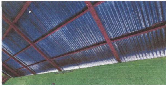
Foto 3: CAMBIO DE LÁMINA DEBIDO A QUE SE ENCUENTRA DAÑADA
