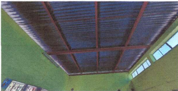
Foto 5: LÁMINAS QUE NECESITAN SER CAMBIADAS
