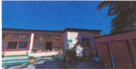
Foto 2: MÓDULO DE SANITARIOS PARA LIMPIEZA DE FOSA SEPTICA
